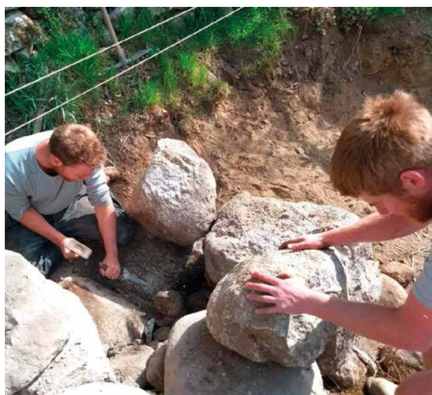
Le rucher de granit en cours de construction abritera des ruches-tronc, en bois de châtaignier, imitant l'habitat des abeilles mellifères vivant à l'état sauvage.
